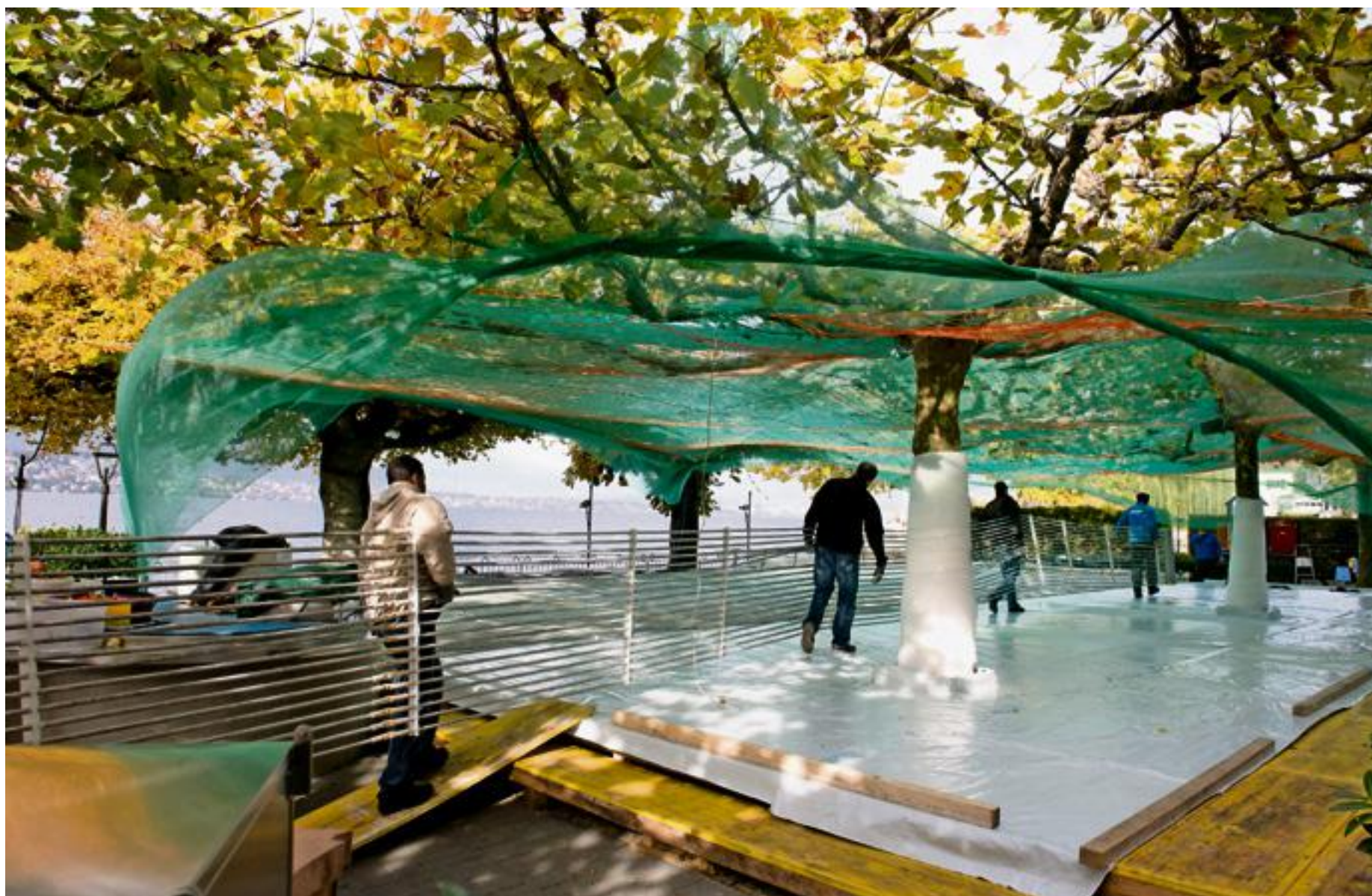
Die Handwerker der Sportprojekt AG tragen einen Teil des Röhrensystems herbei, welches Wasser zu einem Eisfeld gefrieren lässt.
